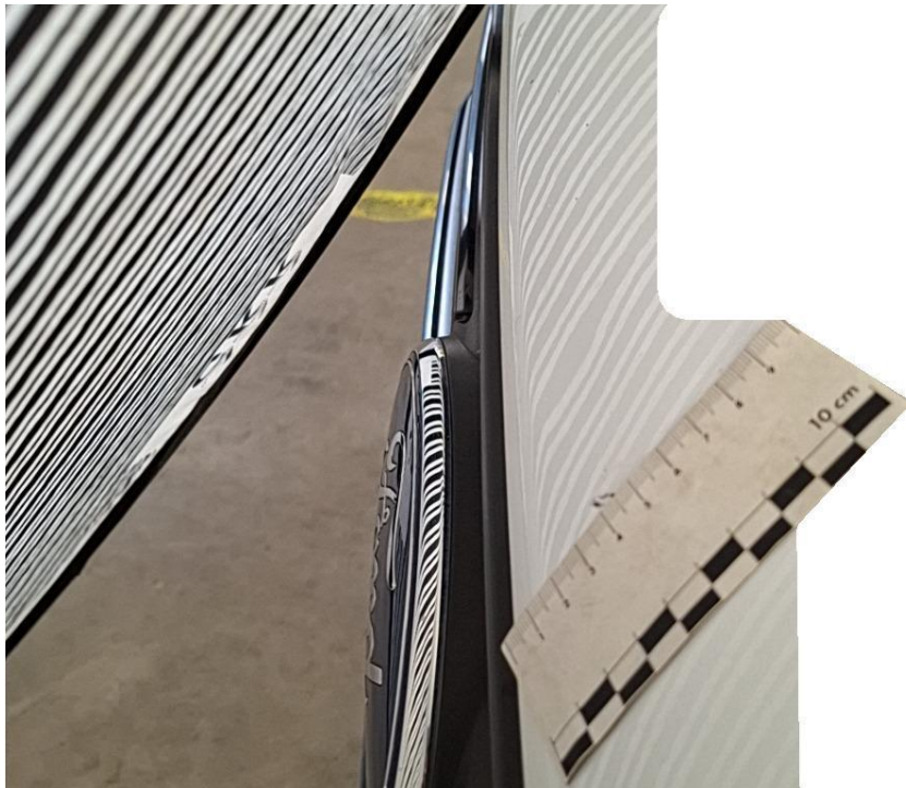
Bild 26 Motorhaube, beschädigt, instand setzen - lackieren
