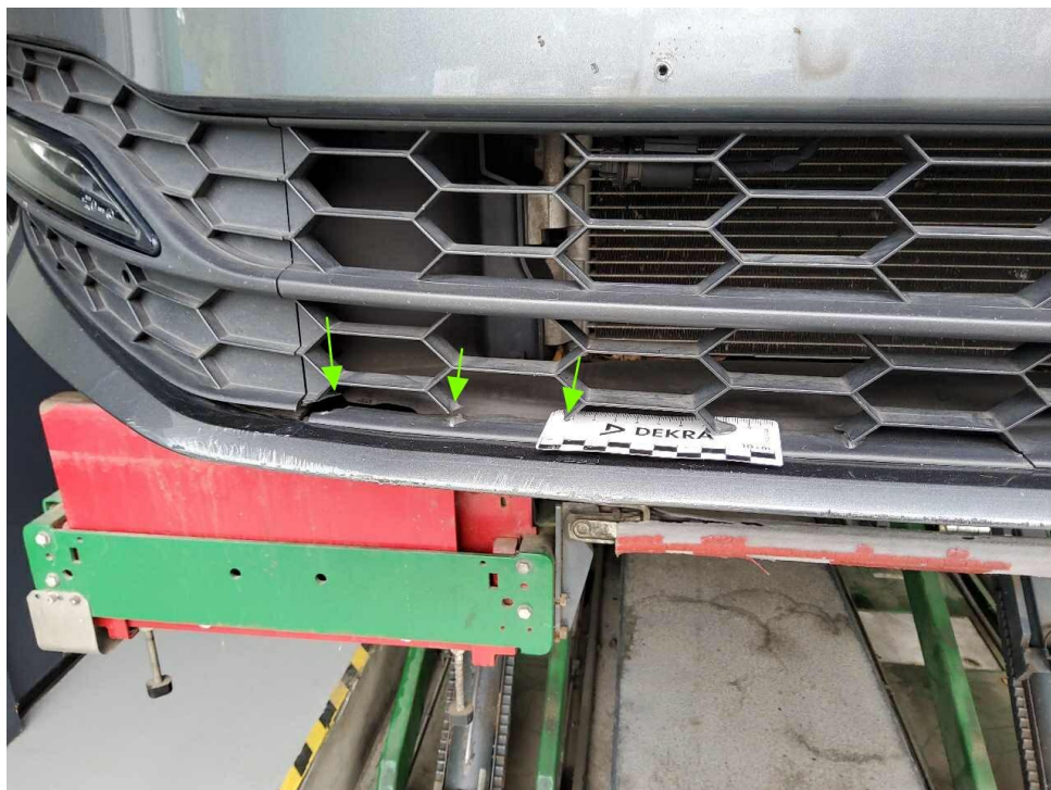
Bild 16 : Stoßfänger vorne Anstoßschaden (inkl. unterer Kühlergrill gebrochen)
