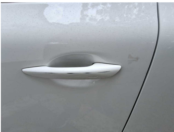
Beschädigung #8: Tür vorn links: Tür - beschädigt - instandsetzen und lackieren
