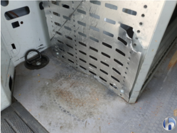
7. Innenraum Beschädigt - Erneuern
