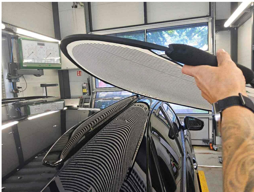
Bild 15 : Hagelschaden, Dachholm rechts
