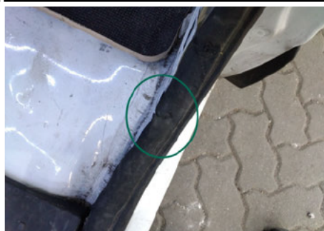
Dichtung Türeinstieg / Rechts / Gebrochen
